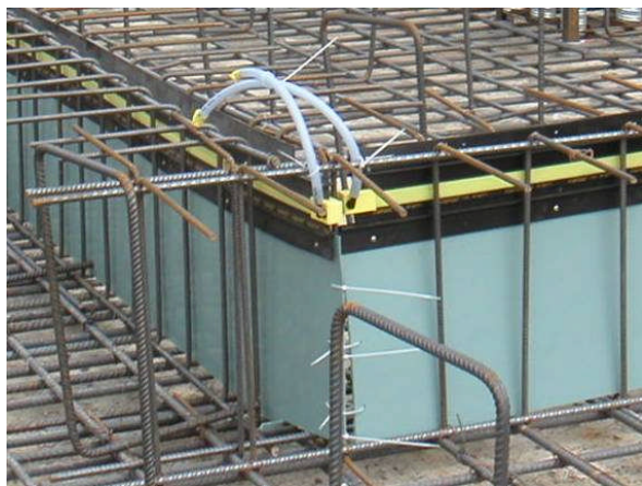
Figura 7. Elemento di prefessurazione
