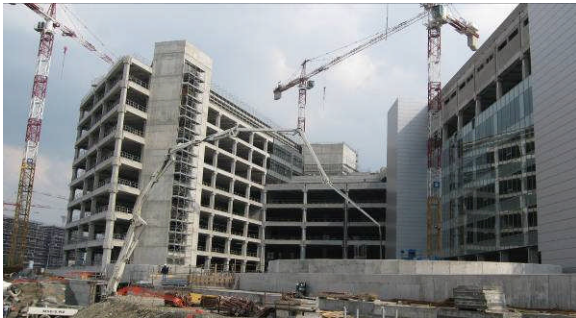
Figura 14. Strutture prefabbricate ed. n.1 e n.2
