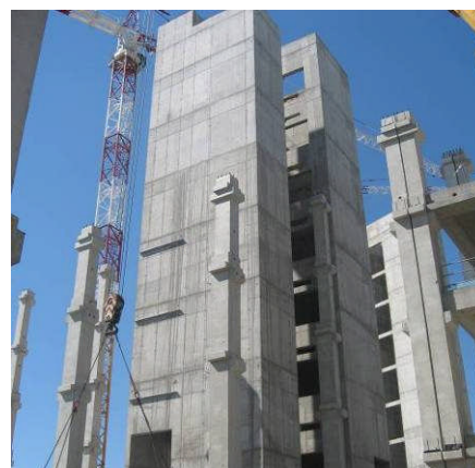
Figura 18. Vista pilastri e muri vani scala
