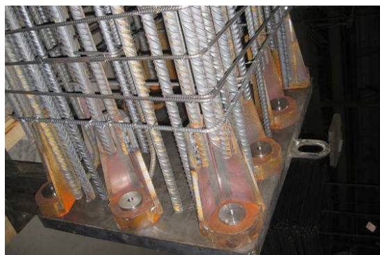
Figura 17. Inserti speciali alla base dei pilastri
