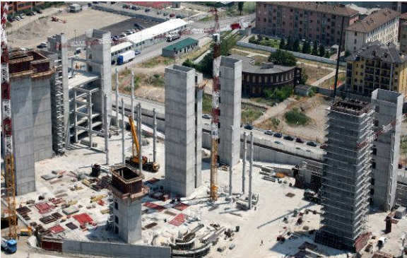
Figura 19. Esecuzione strutture verticali in opera
