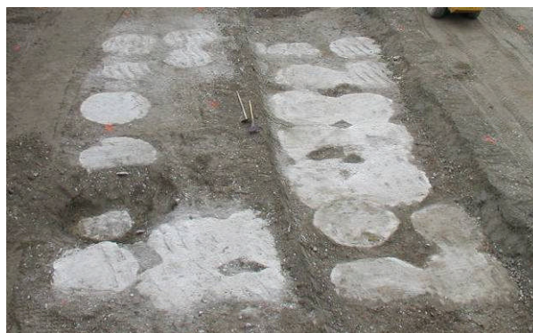
Figura 4. Estradosso Colonne vano scala
