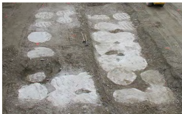
Figura 4. Estradosso Colonne vano scala
