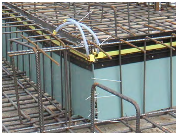
Figura 7. Elemento di prefessurazione
