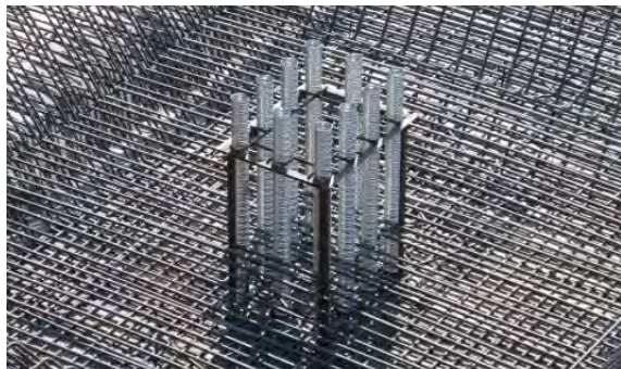
Figura 16. Inserti di collegamento nelle platea
