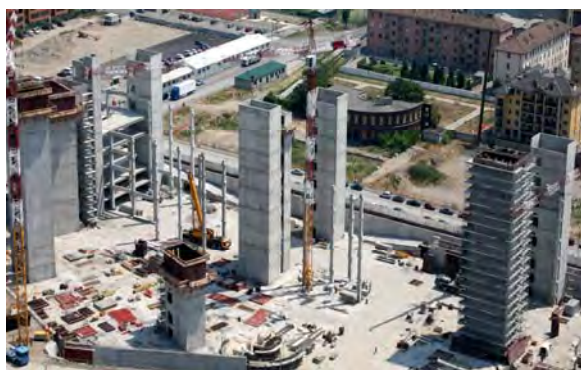
Figura 19. Esecuzione strutture verticali in opera
