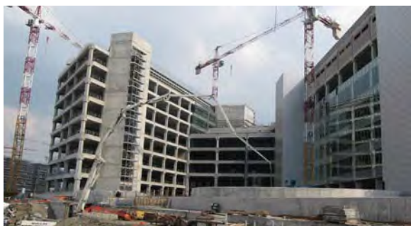
Figura 14. Strutture prefabbricate ed. n.1 e n.2
