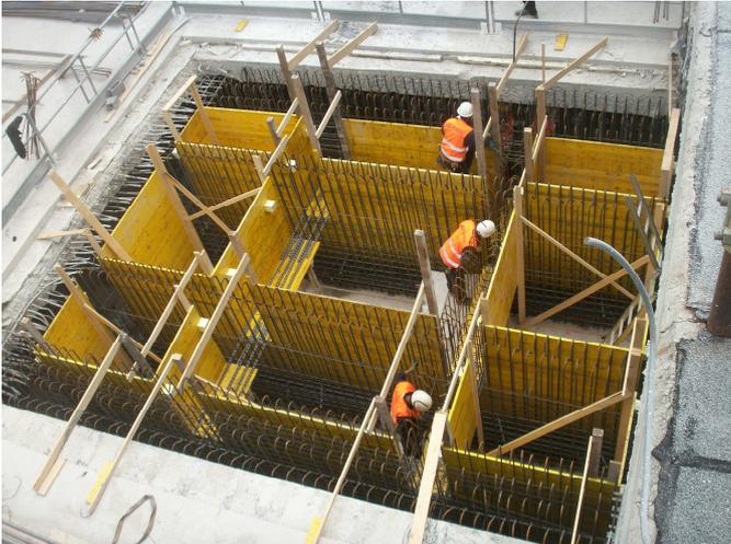
Figure 7. Grid of wall beams / Graticcio di travi parete
