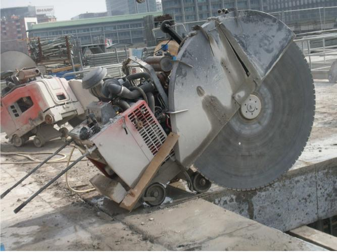
Figure 6. Cutting of existing structures / Taglio delle strutture esistenti
